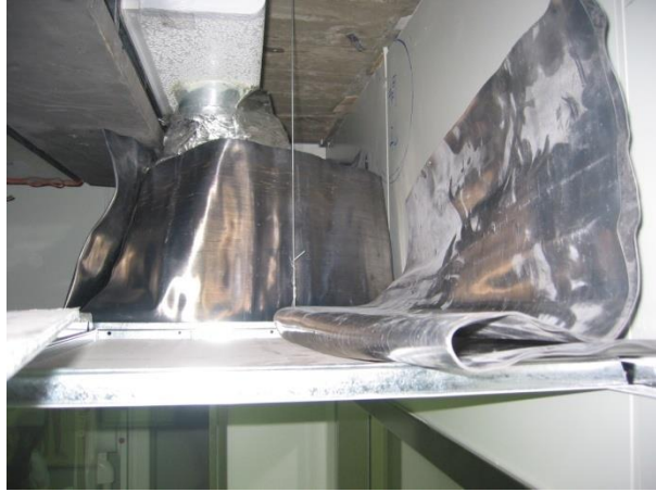
廠商隨意以鉛皮檔住出口情形 控制台鉛玻璃上方: 0.65 \mu\text{Sv/h}
